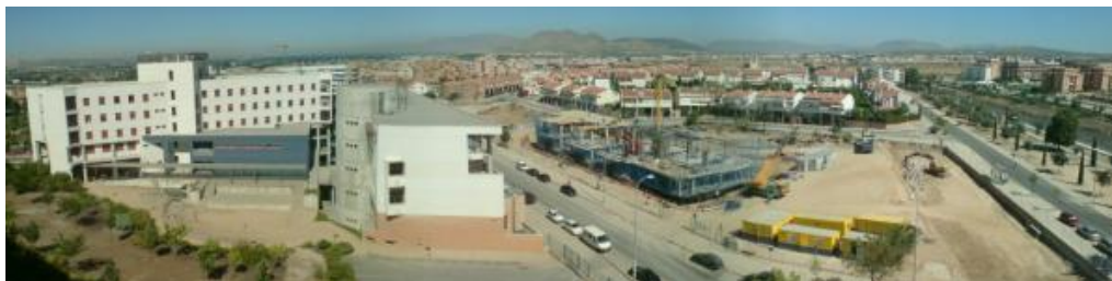
Figura 19: En la parte derecha de esta fotografía puede observarse el CITIC-UGR en construcción. En la parte izquierda se ve la parte posterior del edificio de la ETSIIT.
